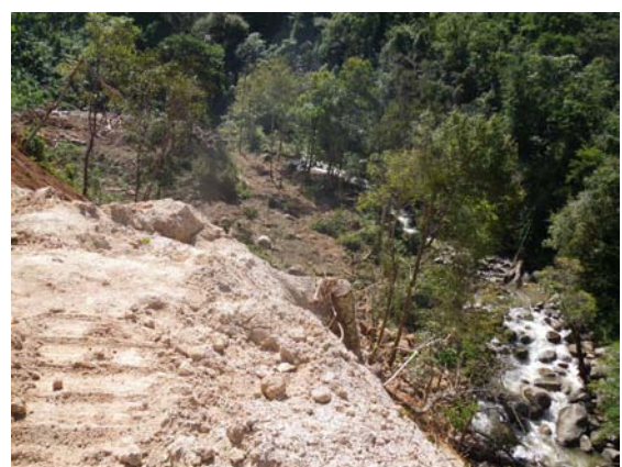
写真－3.7.2 建設状況②(取水設備)
