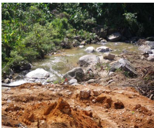
写真－3.7.1 建設状況①(ダム地点)
