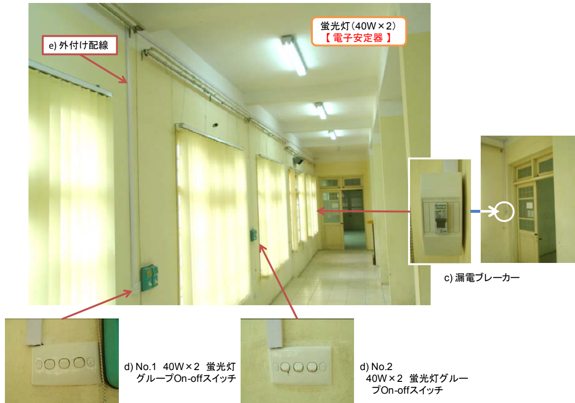
写真 1-11 教室の工事状況
