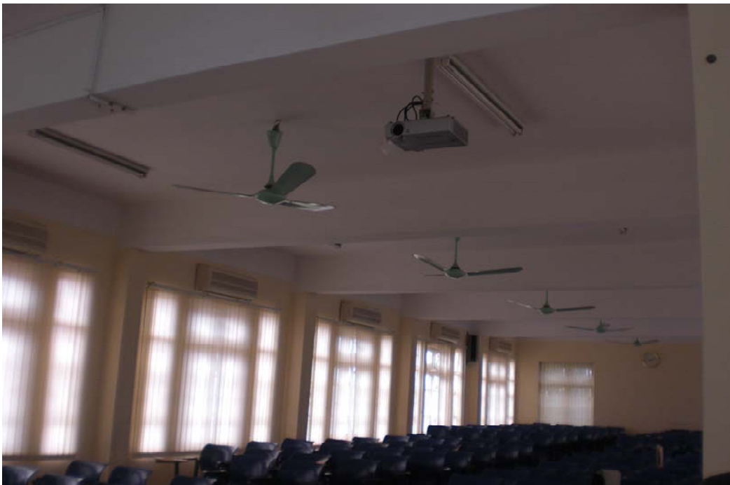
写真 1-7 テスト試験実施個所 (B 棟 502 号室)
