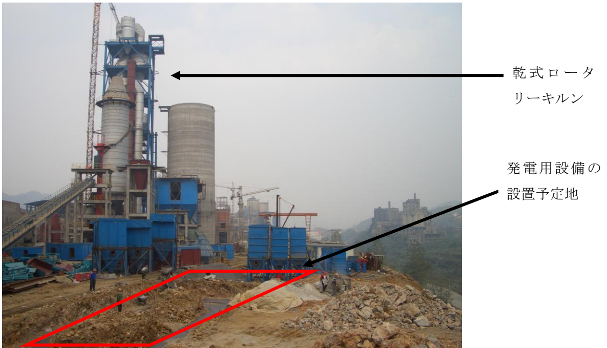
図 2 CPA-1 の建設中のセメント生産ラインの様子と発電設備の設置予定地 (2009年10月撮影)
