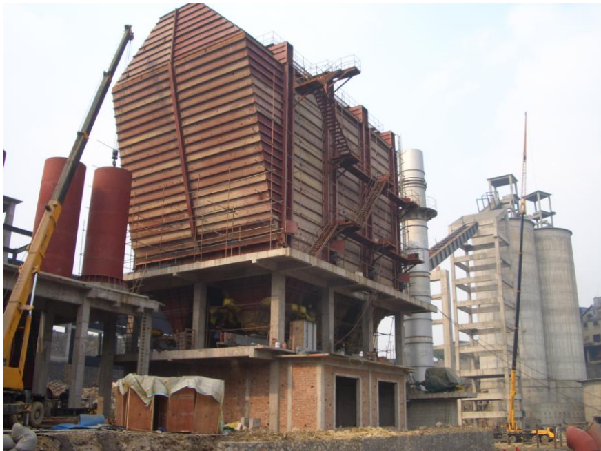
図 22 セメント生産ラインに設置する建設中のバグフィルター（2009年10月撮影）
