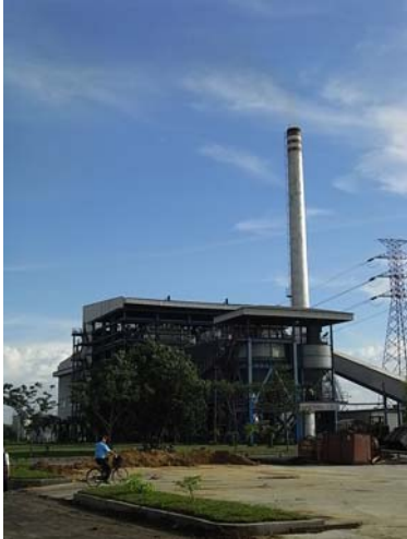
写真 1-1 石炭発電設備
