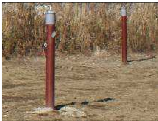
(a) 施工完了
