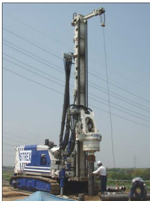
(b) 施工状況
