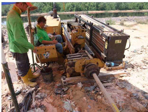
(a) 施工状況
