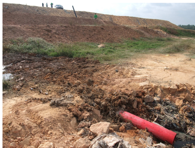
(b) 施工完了
