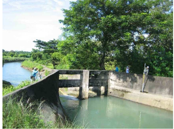
写真 1-4 地形測量の状況
