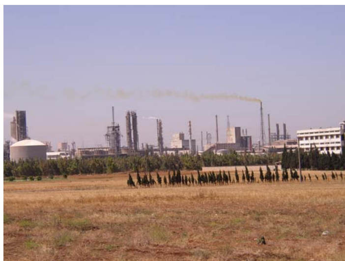
総合化学肥料工場の主要部分 アンモニア製造プラント(写真中央左)
