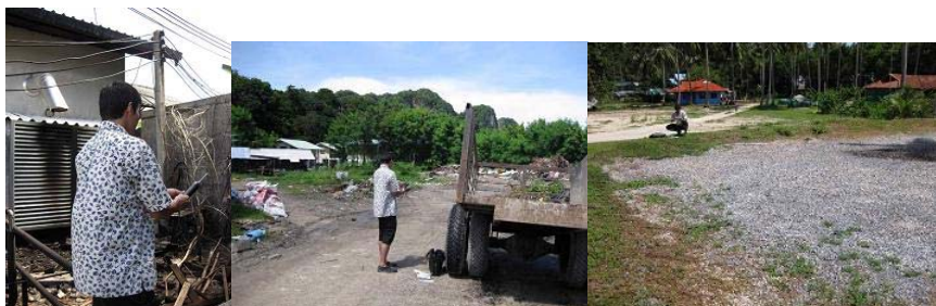
ディーゼル発電機 導入予定サイト オープンポンド上部 Phi Phi Island Villages 施設内の大気測定
