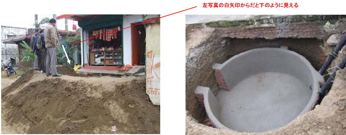
図 4-3 発酵槽建設現場
