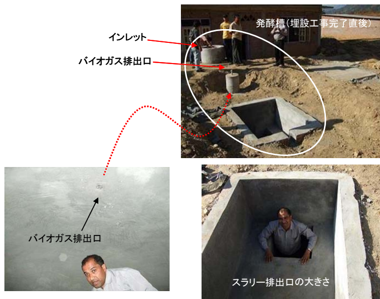
図 4-4 発酵槽建設現場 (埋設工事完了直後)
