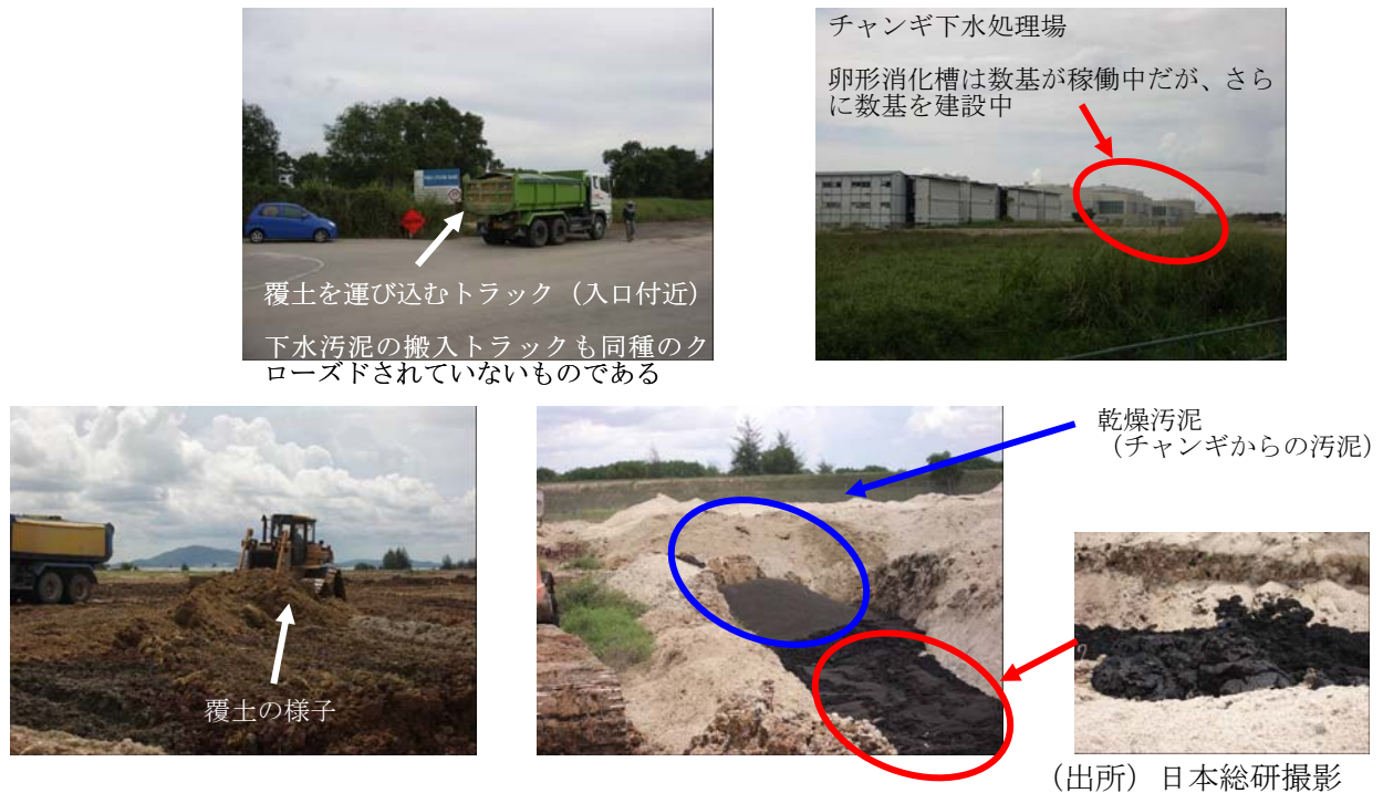
図表 4-3 Changi 下水汚泥埋立処分場の投棄の様子
