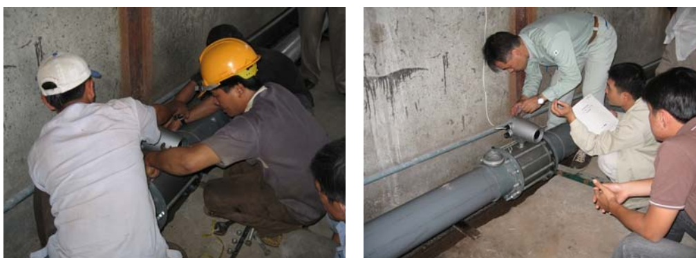
図 2-13 電磁流量計の取付および設定
