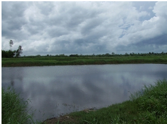
写真 3-5. 浸出水貯留池
