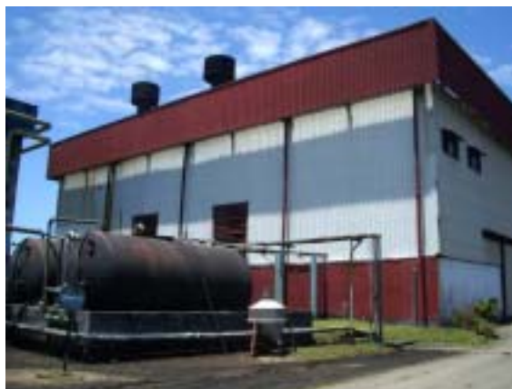
写真 3-1 トアマシナ火力発電所概観
