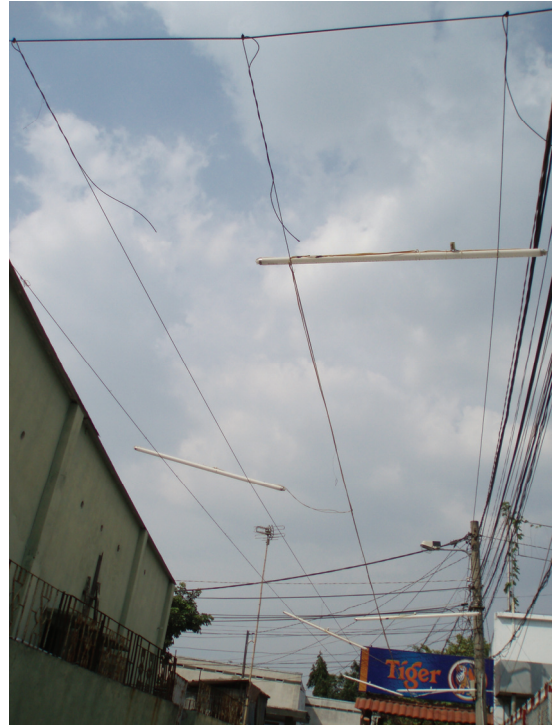
系統電源に無秩序に取り付けられた照明
