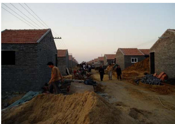
図 9-2. 建設中の第三養豚場
