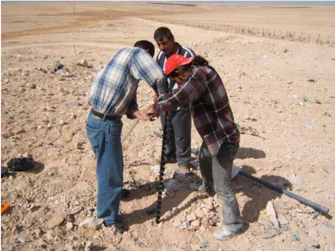
写真 8.1-1 試掘作業風景
