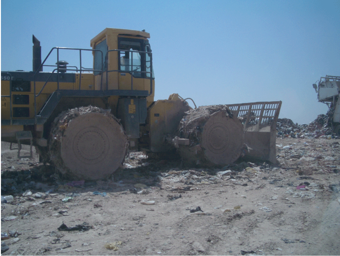
写真 2.4-1 Ghabawi 埋立処分場の現状
