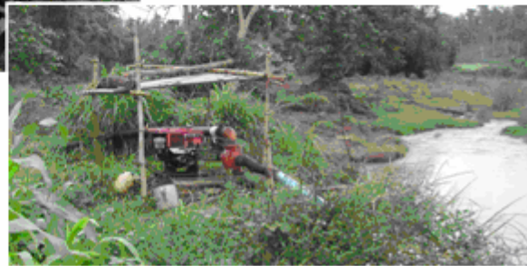
図 5-7 プロジェクト対象地で利用されているディーゼル機器の例 (3)
