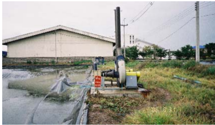
嫌気性ラグーン(Pond 1)ブローター廻り(1)
