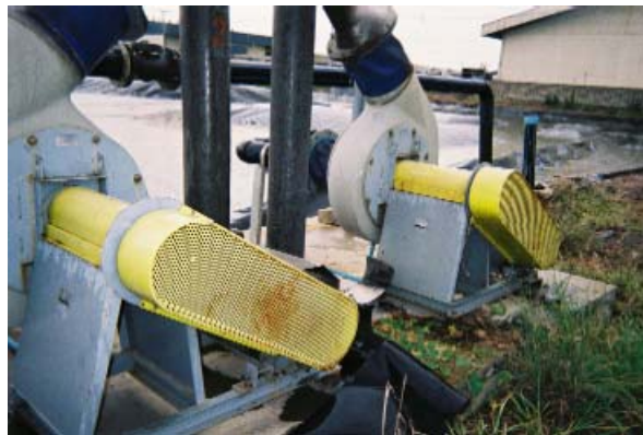
嫌気性ラグーン(Pond 1)ブローター廻り(2)
