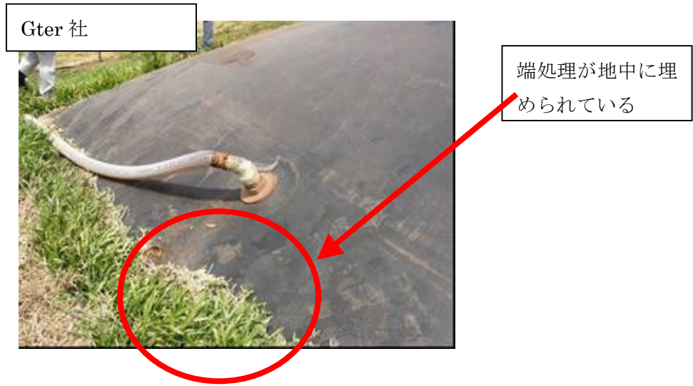
図表 6-2 Gter 社によるバイオダイジェスターの施工
