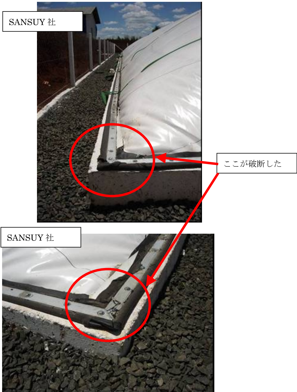
図表 6-1 SANSUY 社によるバイオダイジェスターの施工
