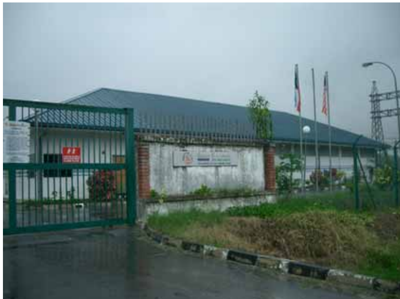
写真 - 2.4.1 Pencawang 変電所
