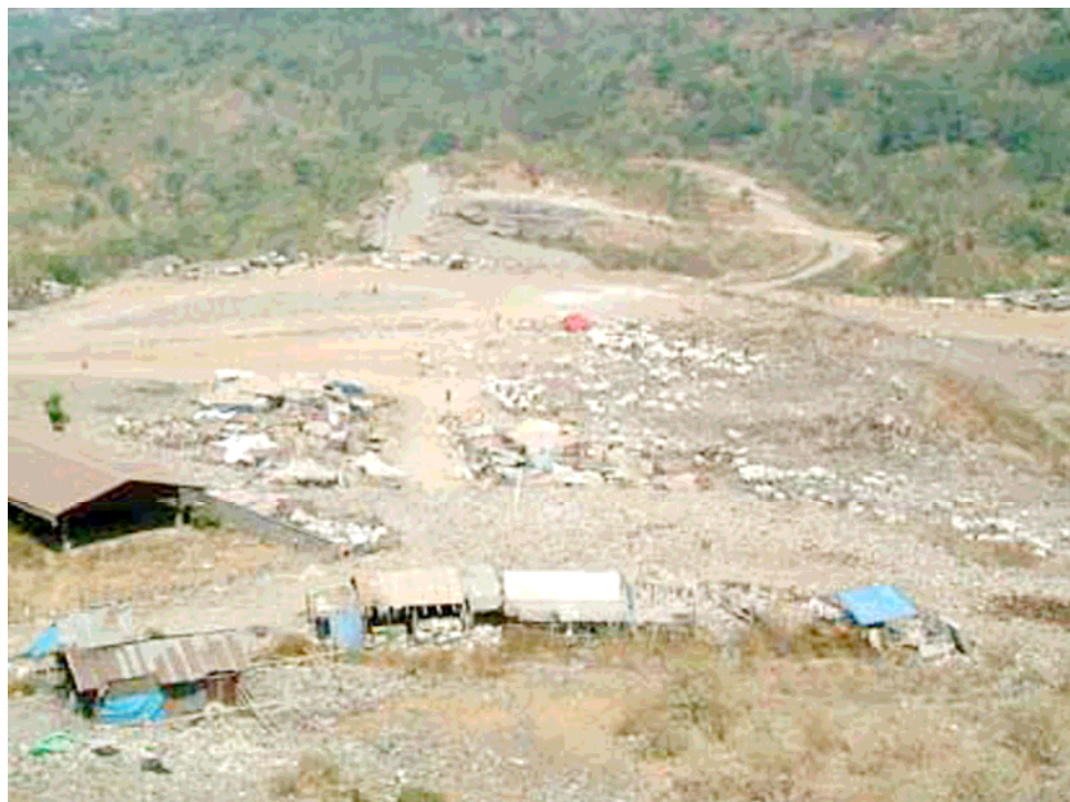
図 2-1-6 ジャティバラン埋立処分場中央部概観
