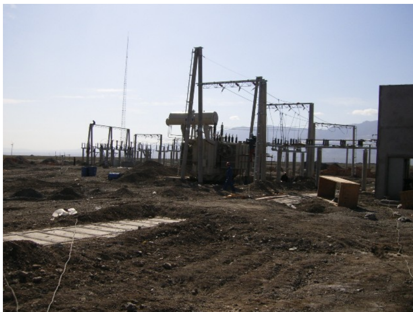
図 4.3 管理事務所に隣接する変電所（1）
