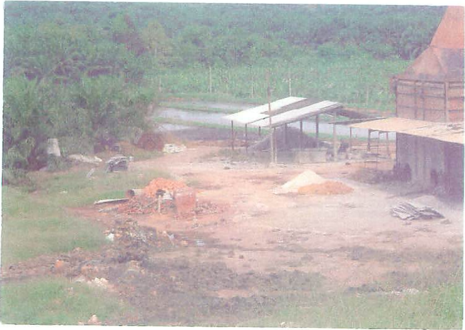
消化槽設置予定地
