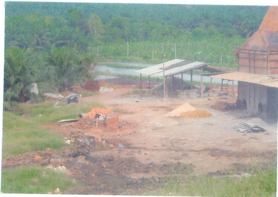
消化槽設置予定地
