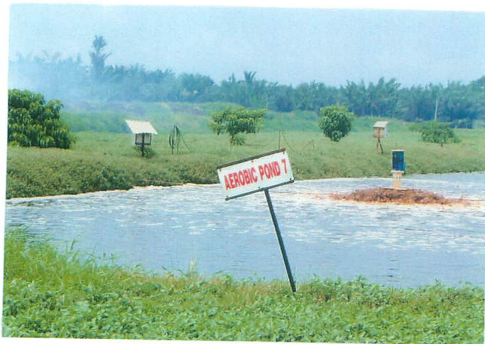
好気性処理ラグーン（曝気中）
