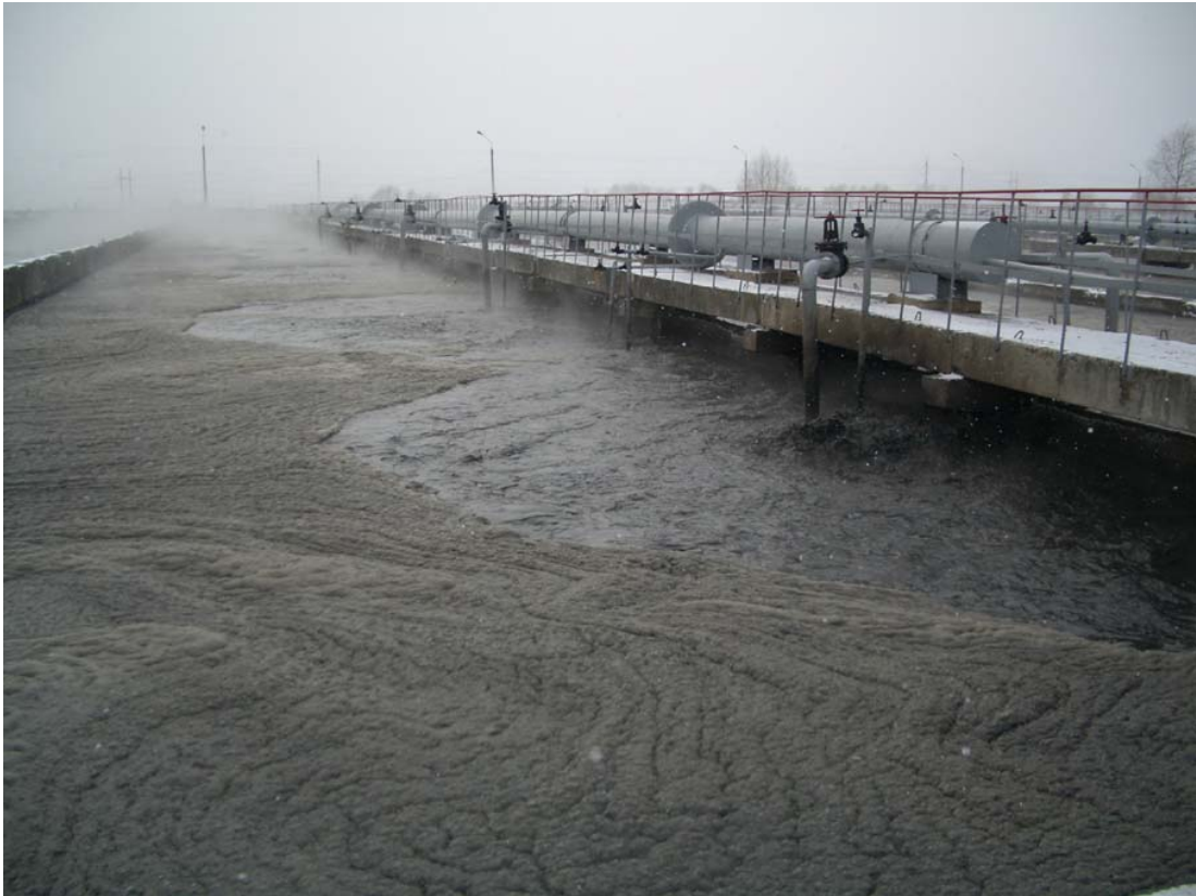
写真 2-5 ボルトニッチ排水処理場（曝気槽）
