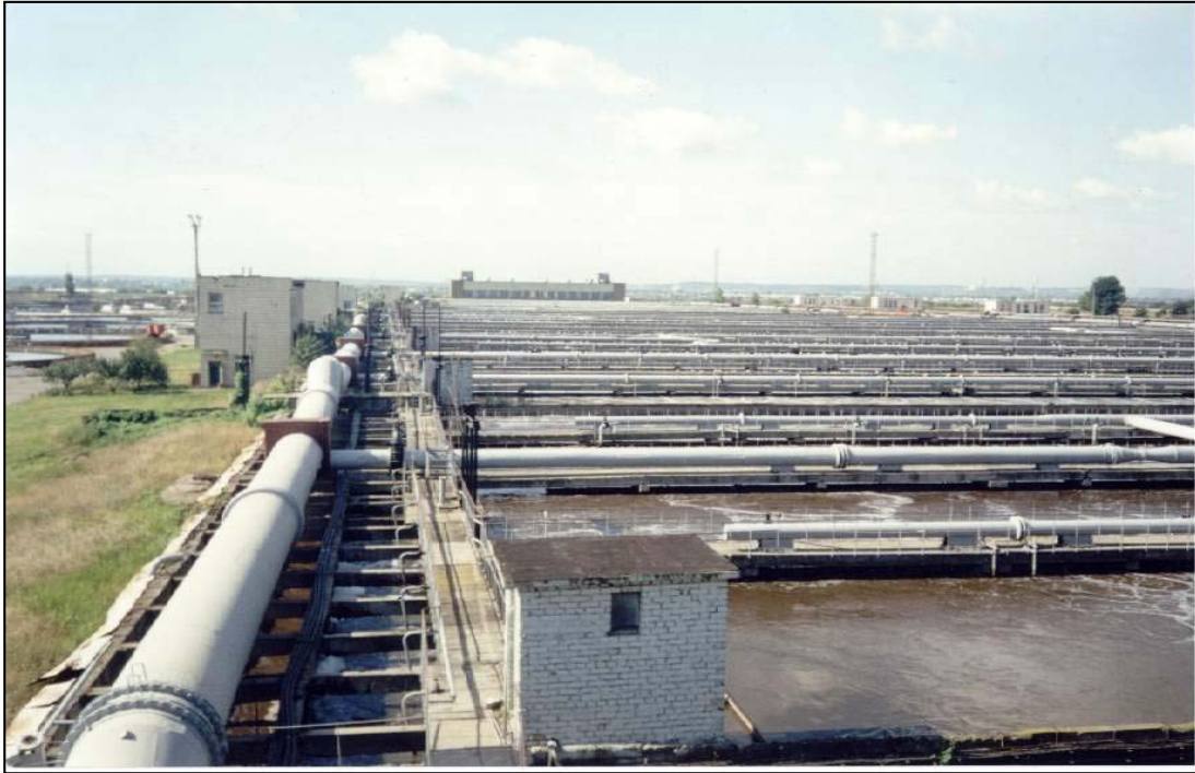
写真 2-3 ボルトニッチ排水処理場（曝気槽）
