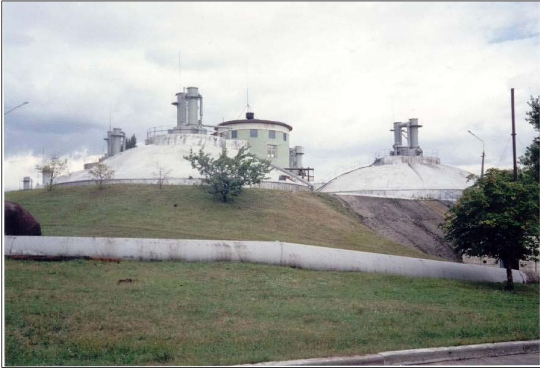
写真-2-6 ボルトニッチ排水処理場（反応槽）
