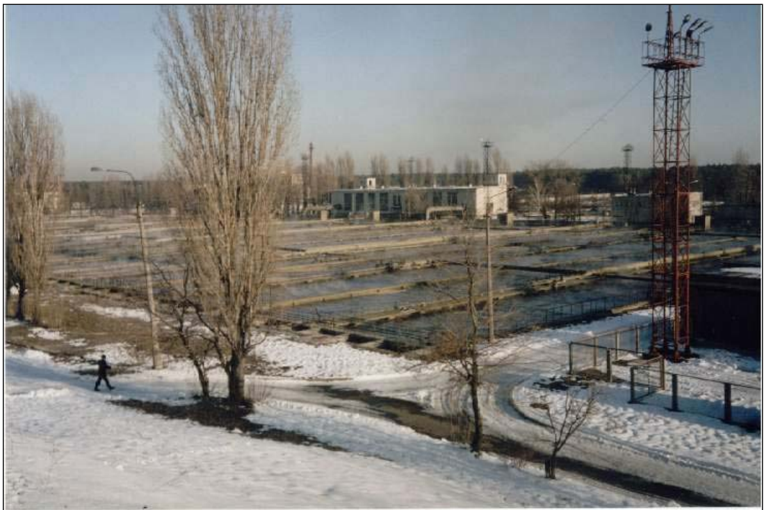
写真 2-2 ボルトニッチ排水処理場（曝気槽）
