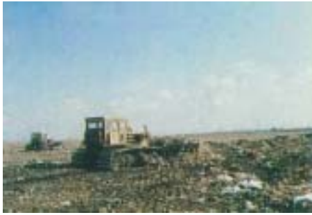
写真 2-3 転圧・敷き均し
