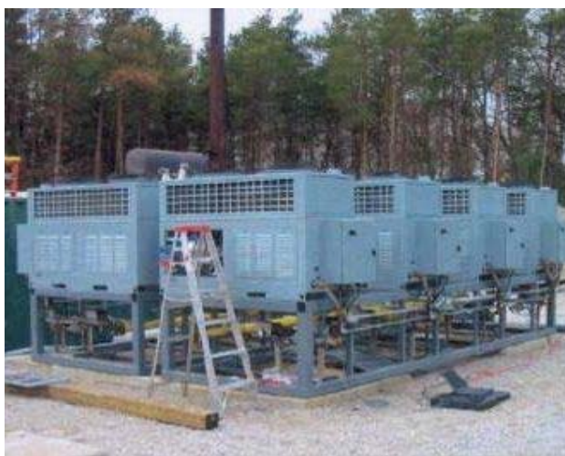
写真 2-5 使用予定のガスエンジン
