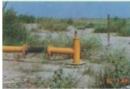
写真 2-4 ガス抜き管
