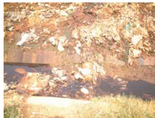
図 4-10 法尻からの浸出水
