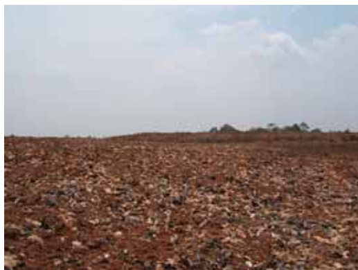
図 4-1 処分場全景(埋立終了部)
