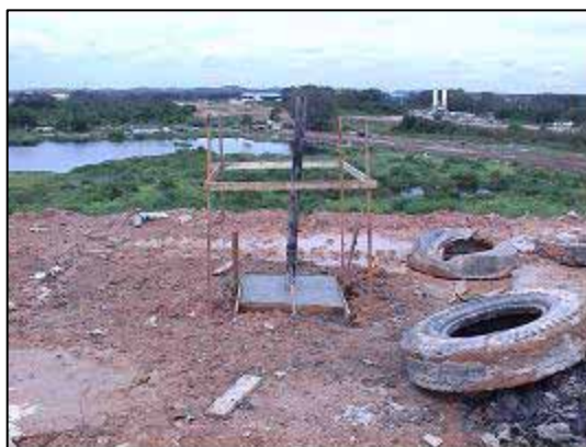
図 4-14 完成した観測用井戸
