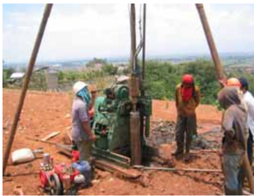
図 5 ボーリング作業状況
