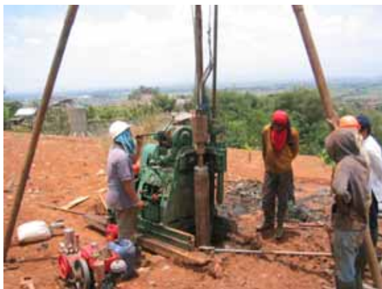
写真 4.1 ボーリング状況 (No.1)
