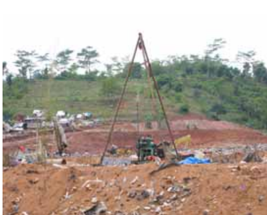
写真 4.2 ボーリング状況 (No.3)
