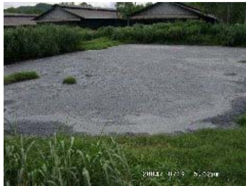
写真1 オープンラグーン入口部
