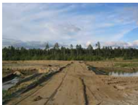
ポリゴン社処分場全景 2
