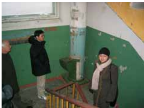
スルゲートの集合住宅における ゴミシューター
