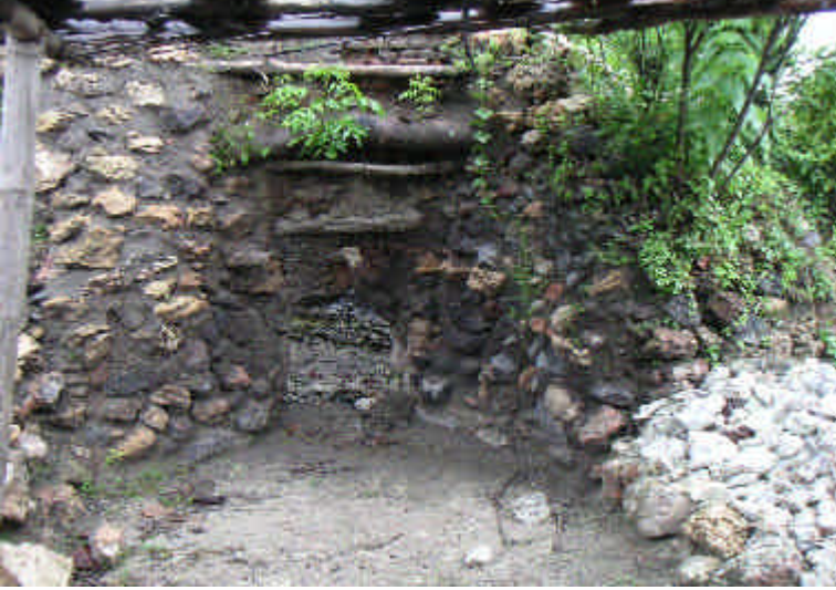
写真20 石灰岩生成のための釜
