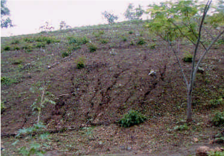
写真 6-1 雨期の驟雨により発生した川
