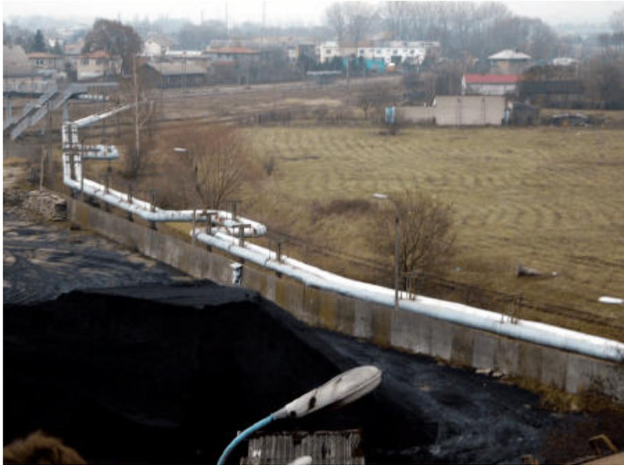
写真 17 熱供給用温水配管
