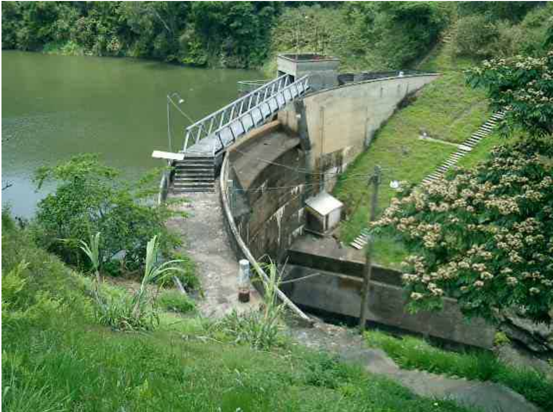
写真 5.4.3-1 AMENAGEMENT 水力発電用のダム 首都アンタナナリボとムラマンガの間にある
