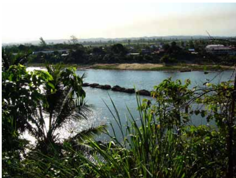
写真 5.4.3-2 プロジェクト候補地に最寄りの「町」であるブリッカビル市にある発電設備遠景
