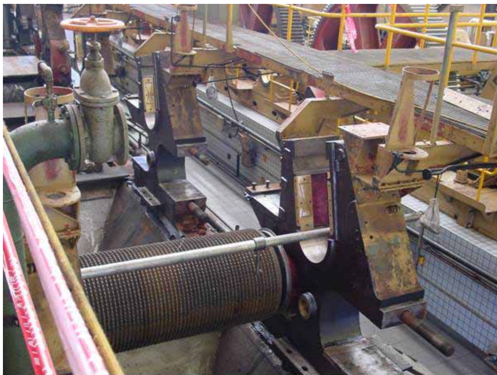
Santa Adelia にてサトウキビ圧搾施設 休止期間中の点検整備
