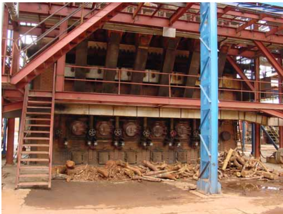
Jalles Mochado 社のボイラー 手前は補助燃料用のユーカリ
