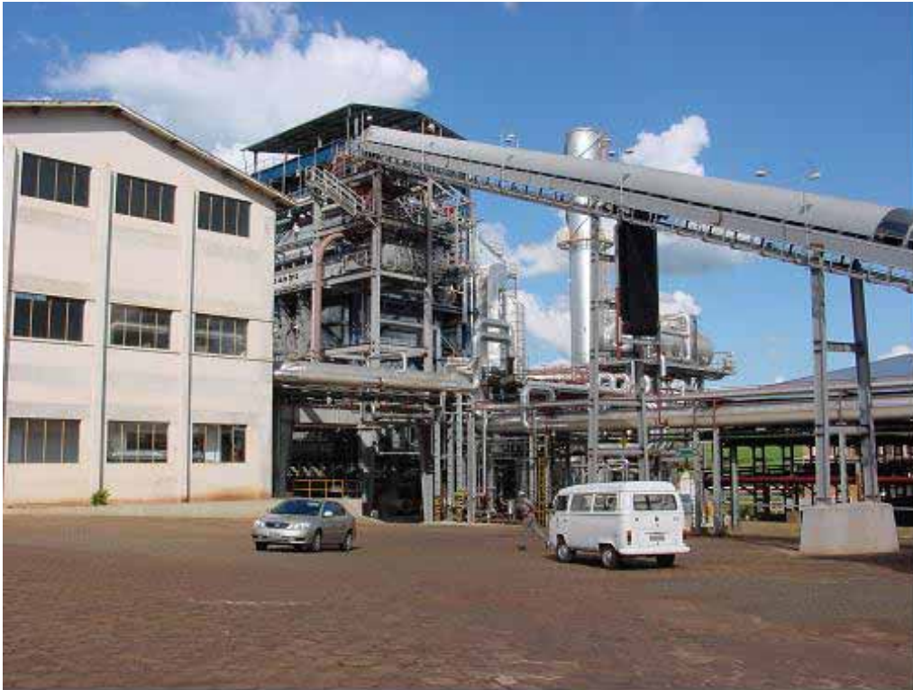
サンパウロ州 Santa Adelia 工場系統給電のため導入された 60kgf/cm 2 ボイラ。中央のベルトでバガスを奥のボイラに搬送する。
