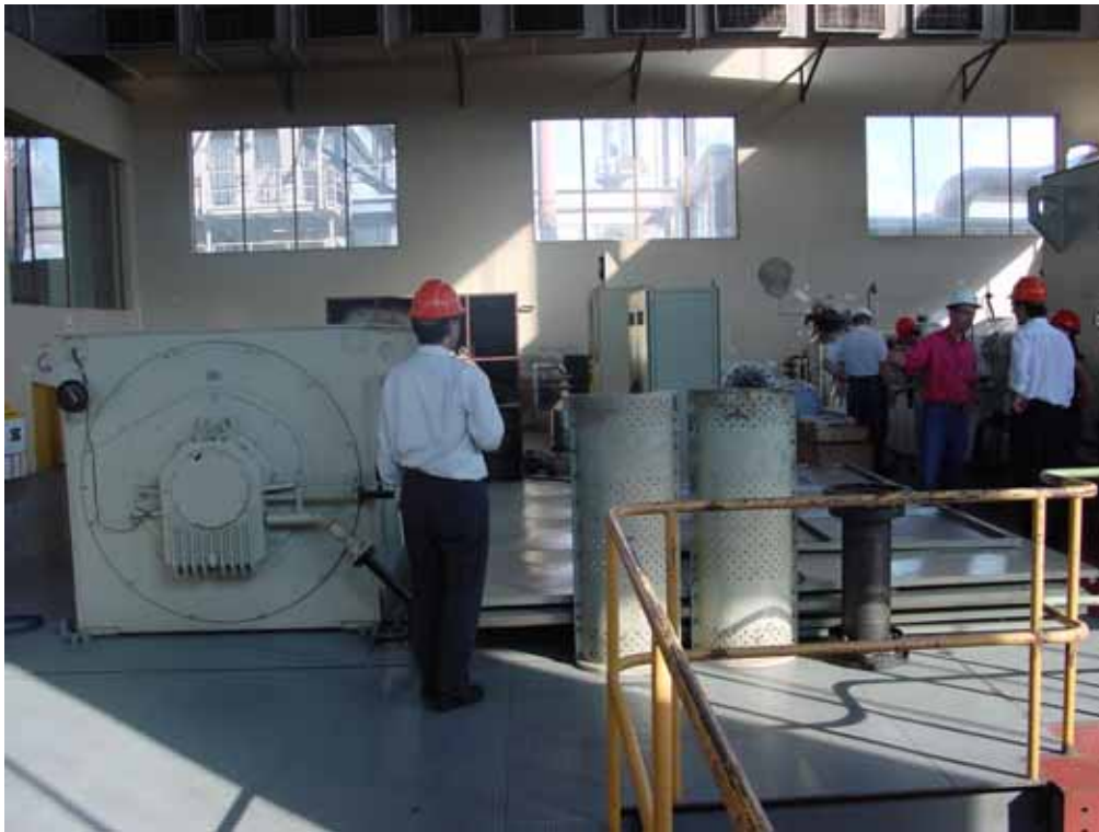
Santa Aderia 社へヒアリングのため訪問 休止期間中の発電機等分解点検整備
