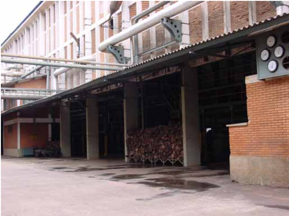
Rosario 社ボイラー
