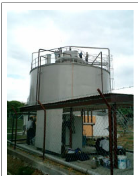
図表 1 - 2 500m 3 メタン発酵モデルタンク
