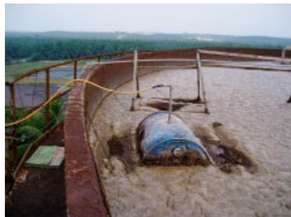
図表 2 - 19 開放型消化タンクに浮かぶチェンバー
