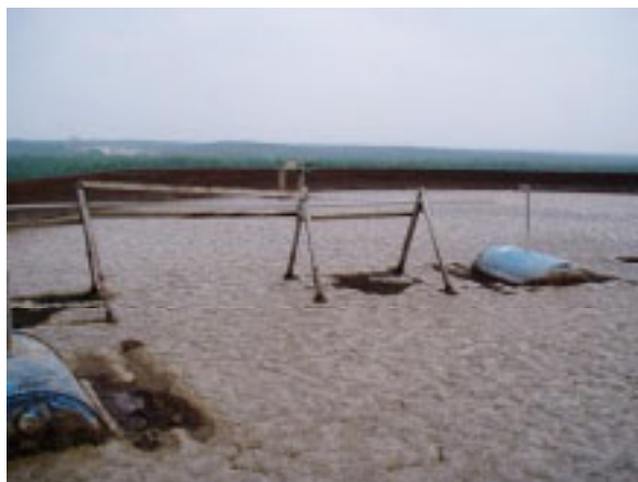
図表 2 - 19 開放型消化タンクに浮かぶチェンバー
