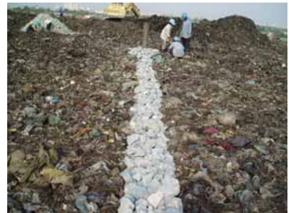
横みぞ設置工事
