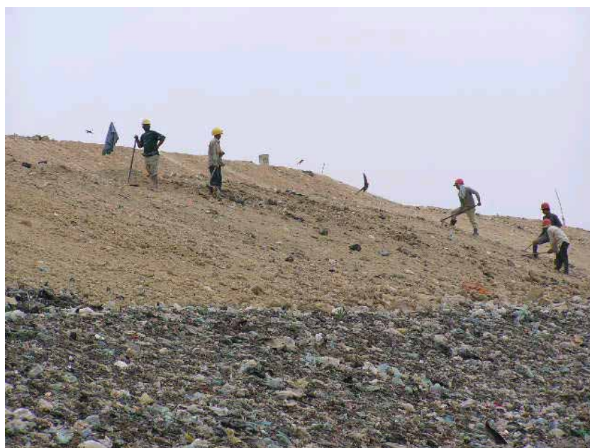
図 3.5 実験サイトの法面覆土工事
