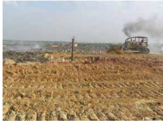
実験サイトの覆土工事
