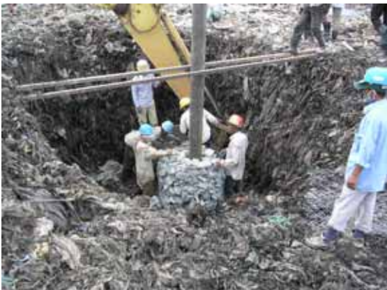
ガス抜き管立て込み工事
