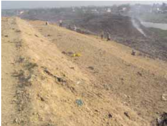
法面に施工された覆土
