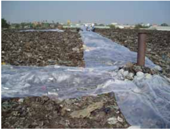
横みぞを覆うビニールシート工事
