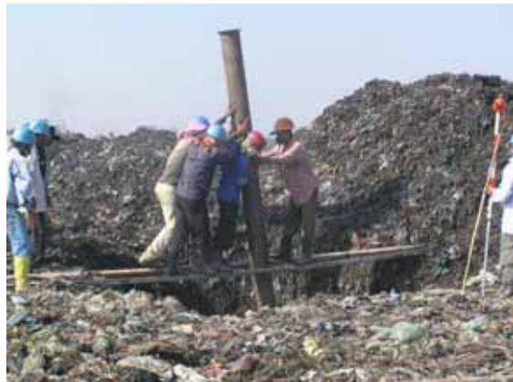
ガス抜き管立て込み工事
