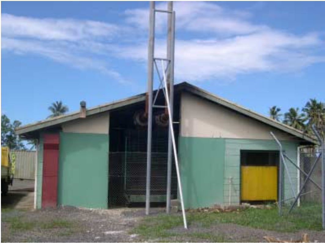
写真 1 0 自家発電設備
