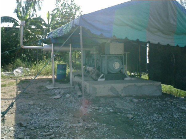
第三回現地調査 2002年10月29日 ラチャテワ衛生埋立地視察 LFG用 ガスエンジン発電機
