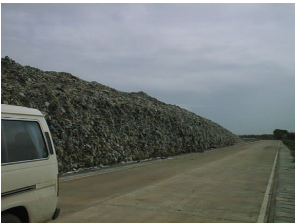
第二回現地調査 2002年9月9日 ハナフリダンプサイト現地視察 ダンプサイト北西より西方向を望む
