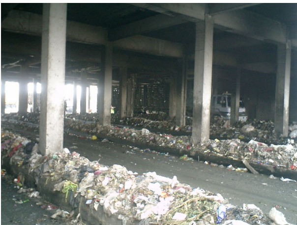
第三回現地調査 2002年10月29日 ターラン トランスファーステーション 廃棄物積替え施設 搬出車用ピット
