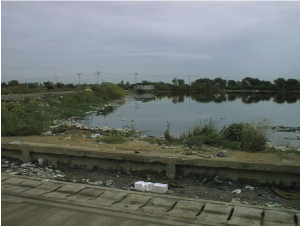
第二回現地調査 2002年9月9日 ハンブリタンピングサイト現地視察 Landfill B 建設予定地 (タンピングサイト西側)
