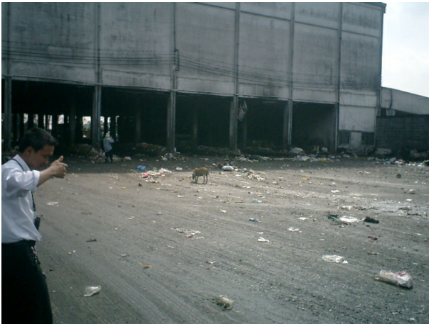
第三回現地調査 2002年10月29日 ターラン トランスファーステーション 廃棄物積替え施設 搬出車用ピット全景
