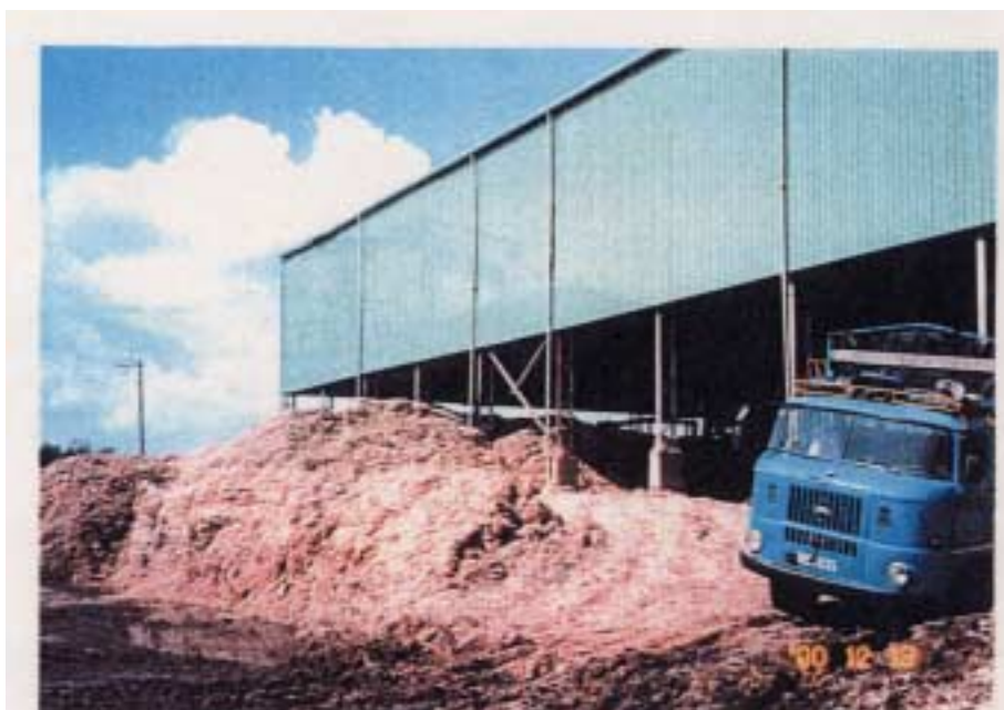
南部：ビン・ホア第2工場・バガス置き場
