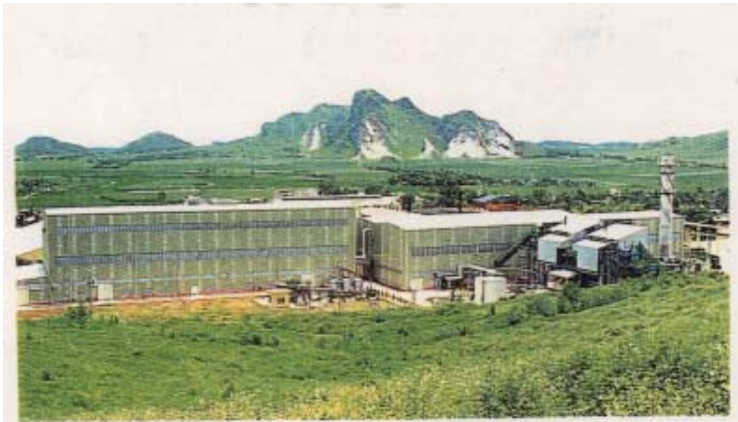
北部：ラム・サン工場・外観
