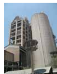
セメント工場における廃熱利用発電(インドネシア)
