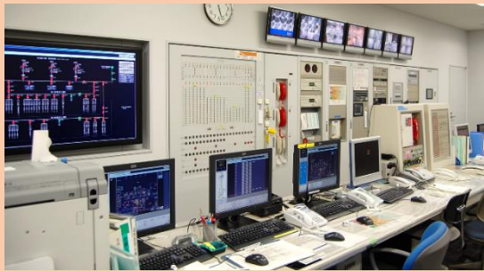
中央監視システム
