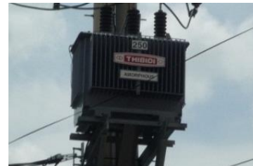
高効率電力変圧器 (裕幸計装) 電力変圧器 金属：日立金属製
