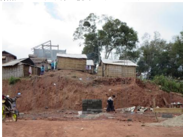
住民による中学校の寮拡張作業
