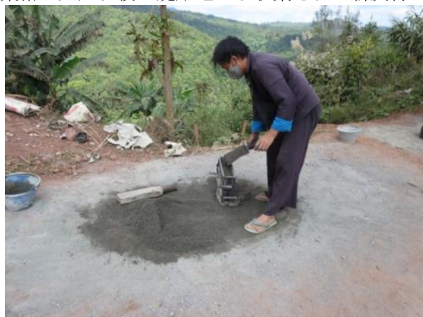
住民による中学校の寮拡張作業（ブロック作り）
