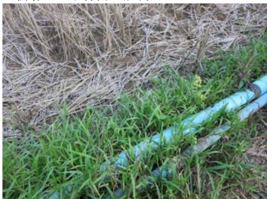
灌漑の配水パイプ
