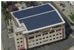
太陽光発電 (パナソニックエネルギー) 太陽 光パネル: 京セラ製
