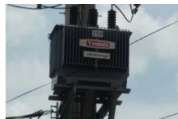
高効率アモルファス変圧器 (裕幸計装) アモルファス金 属: 日立金属製
