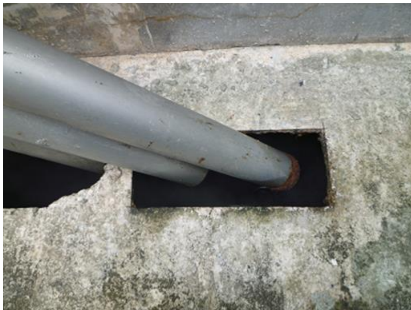
図 4-1-4 染色機からの排水管(通常 2 系統の排水管が備わっている)
