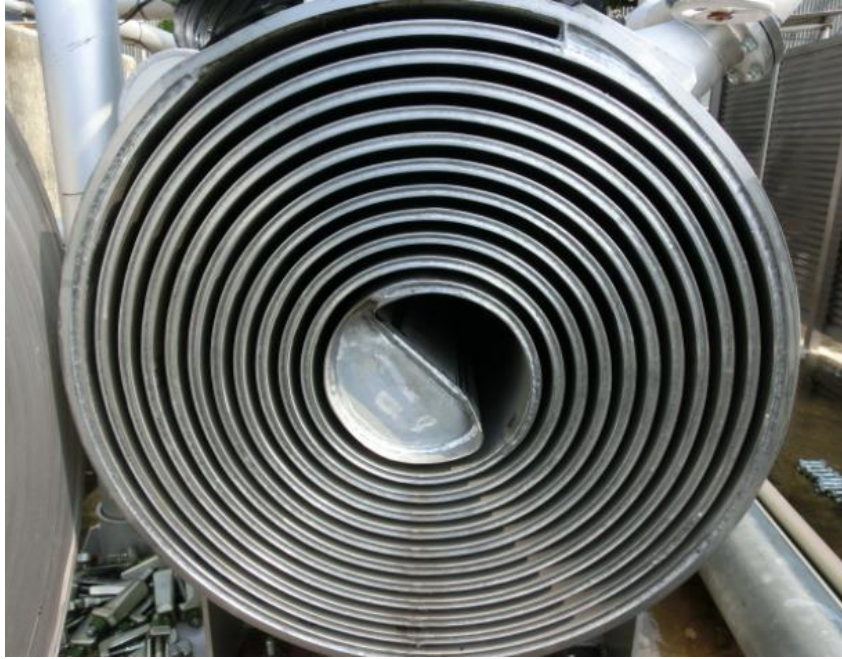
図 4-3-6 5 年間使用後のカバーを開放したスパイラル式熱交換器(ディスタンススペースなし)の内部の状況(汚れ・つまりがほとんどない) 14
