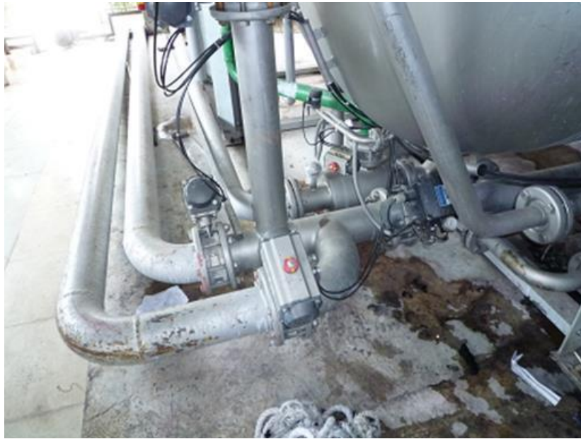
図 4-1-3 染色機の排水管(電磁バルブが取り付けられている)
