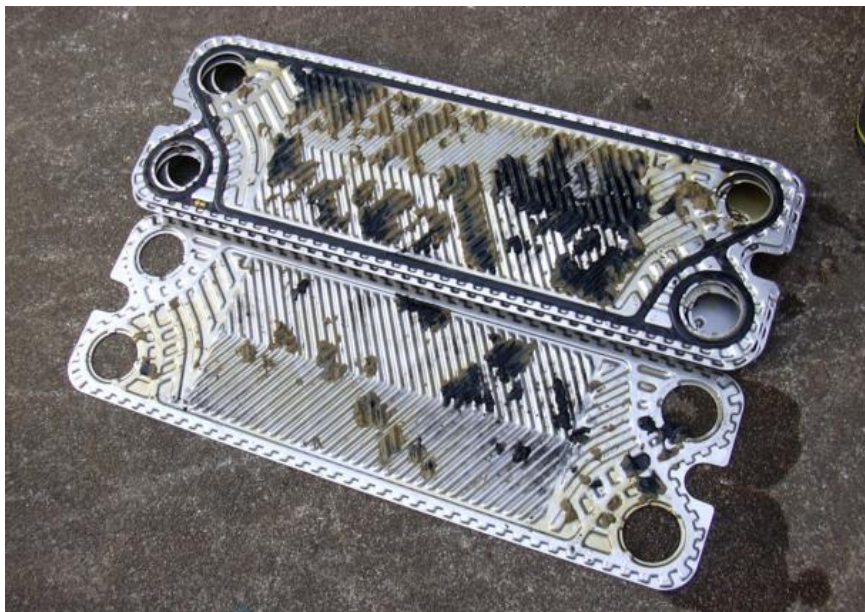
図 4-3-5 閉塞し分解したプレート式熱交換器の状況 13
