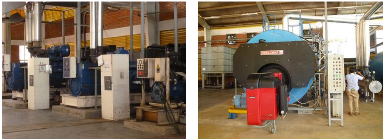
図 2-1-5 Giant 工場のディーゼル発電機(左)とガス炊きボイラー(右)
