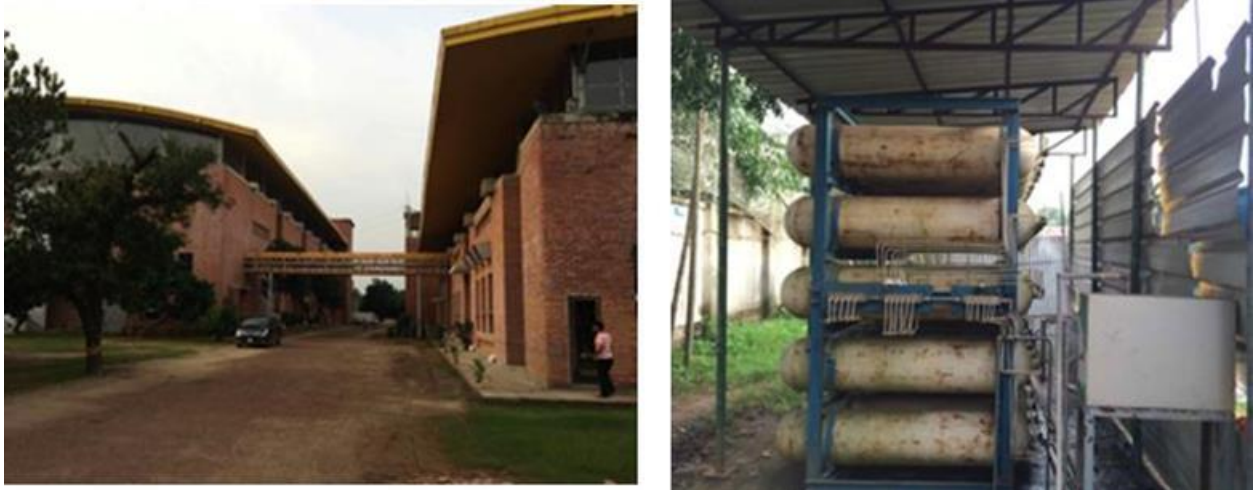
図 2-1-4 Giant 工場の建物(左)及び CNG 貯蔵用ボンベ(右)
