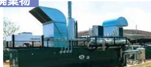
メタンガス回収発電 (メキシコ) ) NTT データ経営研究所
