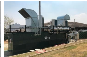
メタンガス回収発電 (NTTデータ経営研究所)
