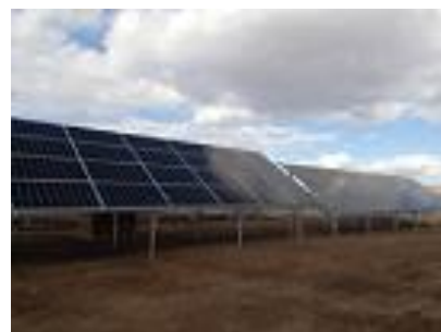
太陽光パネル
