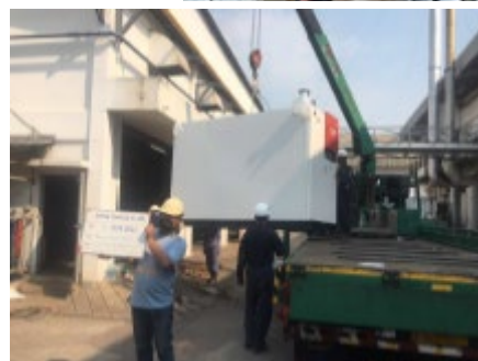
貫流ボイラの搬入
