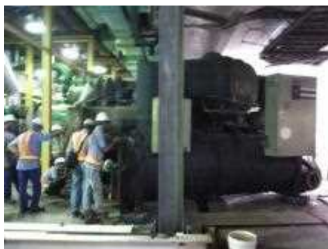
既存冷凍機搬出
