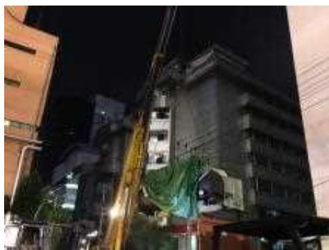
トレーラーから冷凍機の荷卸し
