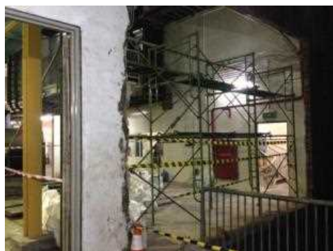
搬入経路壁解体
