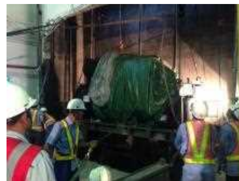
シャフトから冷凍機を揚重
